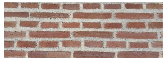
Abbildung: Es sind keine Ziegel ! Es handelt sich um einen Wandausschnitt aus Geopolymer-Steinen.
