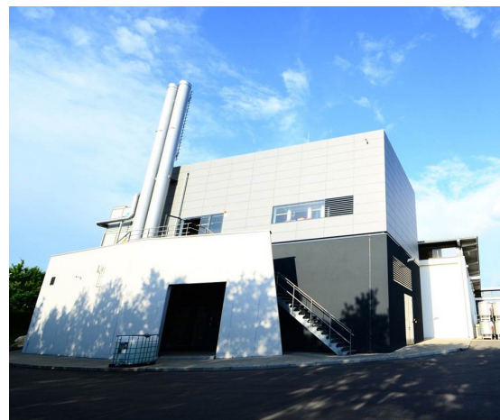
Abb. 1: Vorderansicht der Energiezentrale in einer Molkerei. (Quelle: AGO AG Energie + Anlagen)
