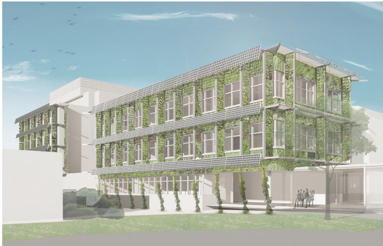
Abb. 9 Visualisierung Fassadenkonzept Begrünung mit Photovoltaik am Beispiel des Verwaltungsbaus von SUN in Nürnberg
