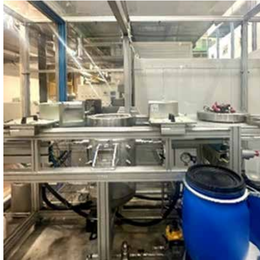
Abb. 40 1-m 3 -Nachbehandlungsofen zur thermischen Konditionierung von Aerogelpartikeln. (TUHH-TVV)
