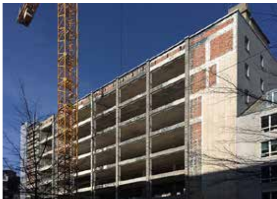
Abb. 1 München, ehemalige Amtsgericht / Betreuungsgerecht vor Umbau (11/2017) (Foto: Roland Krippner)
