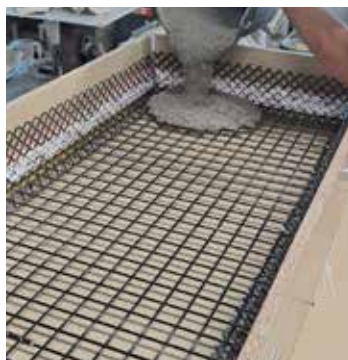
Abb. 54 Flächenarmierung und Betonage (Meier)
