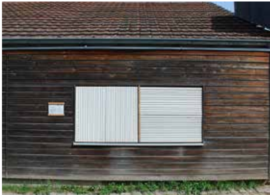
Abb. 7 Fassadezustand mit strukturierten Holzleichtbetonplatten als Fassadenbekleidung, 22.05.2014 (Foto: Roland Krippner)
