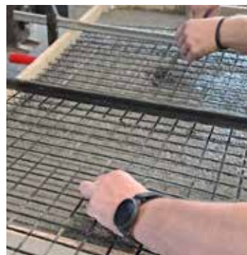
Abb. 56 Einarbeiten zweite Be- wehrungslage (Meier)
