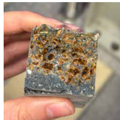
Abb. A269 Bruchfläche nach BZFP
