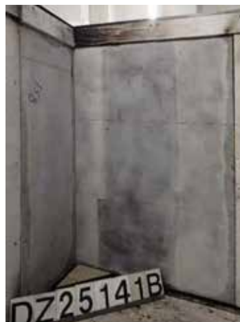
Abb. A97 Prüfkörper DZ3.1/25-141B / Ansicht des großen Flügels vor der Brandprüfung. (MFPA Leipzig, 17. September 2025b)
