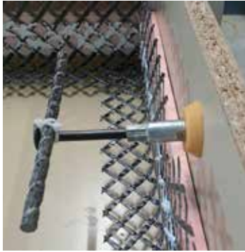
Abb. A65 Randarmierung mit Abhebeanker (Meier)
