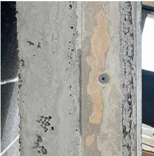
Abb. A71 Funktionsmodell I (fm.I.a) – Aufbau von der Schmalseite: Tragschicht (links), Randdämmung (mitte), Vorsatzschicht (rechts) (Ohm-AR)
