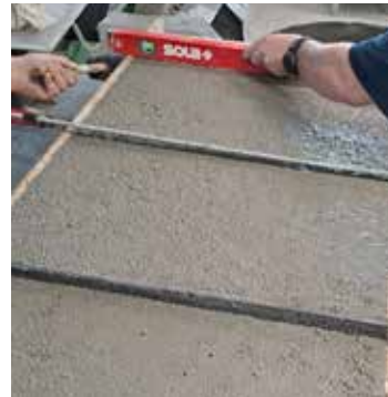
Abb. A70 Abziehen der Betonoberfläche Tragschicht (Meier)
