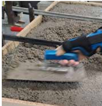
Abb. A69 Betonage Tragschicht (Meier)
