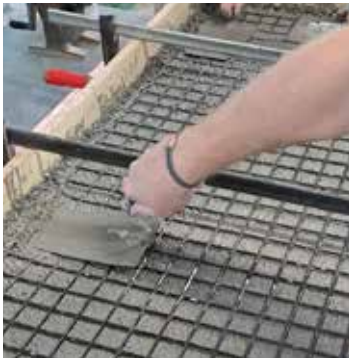
Abb. A68 Einarbeiten erste Bewehrungslage (Meier)
