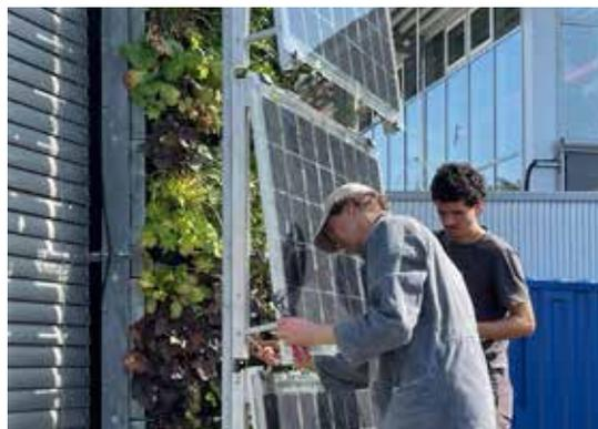
Abb. 54 Montage mittleres geneigtes PV-Modul (7,5°) vor Variante 2 Kramer (September 2023) (THN-AR)
