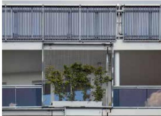
Abb. 4 Kletterpflanzen in horizontalen Substratträgern und Brüstungen mit Dünnschicht (aSi) PV-Modulen (THN-AR)
