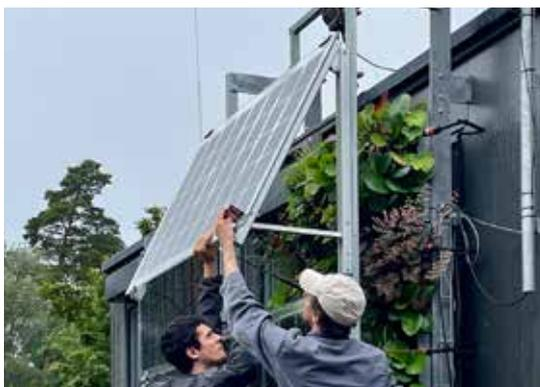
Abb. 53 Montage oberes geneigtes PV-Modul (30°) vor Variante 2 Kramer (August 2023) (THN-AR)
