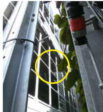
Abb. 34 Oberflächentemperaturfühler an Rückseite der PV-Module (gelb umrandet) (THN-ieg)
