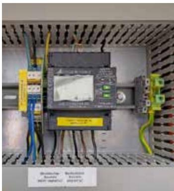
Abb. 35 Energiezähler der Firma Gossen Metrawatt (THN-ieg)
