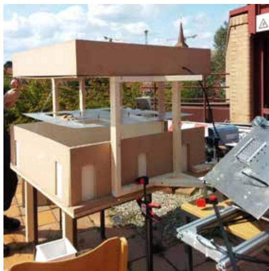
Abb. 54 Montage der abgehängten Decke zur Aufnahme der lichtleitenden Fasern
