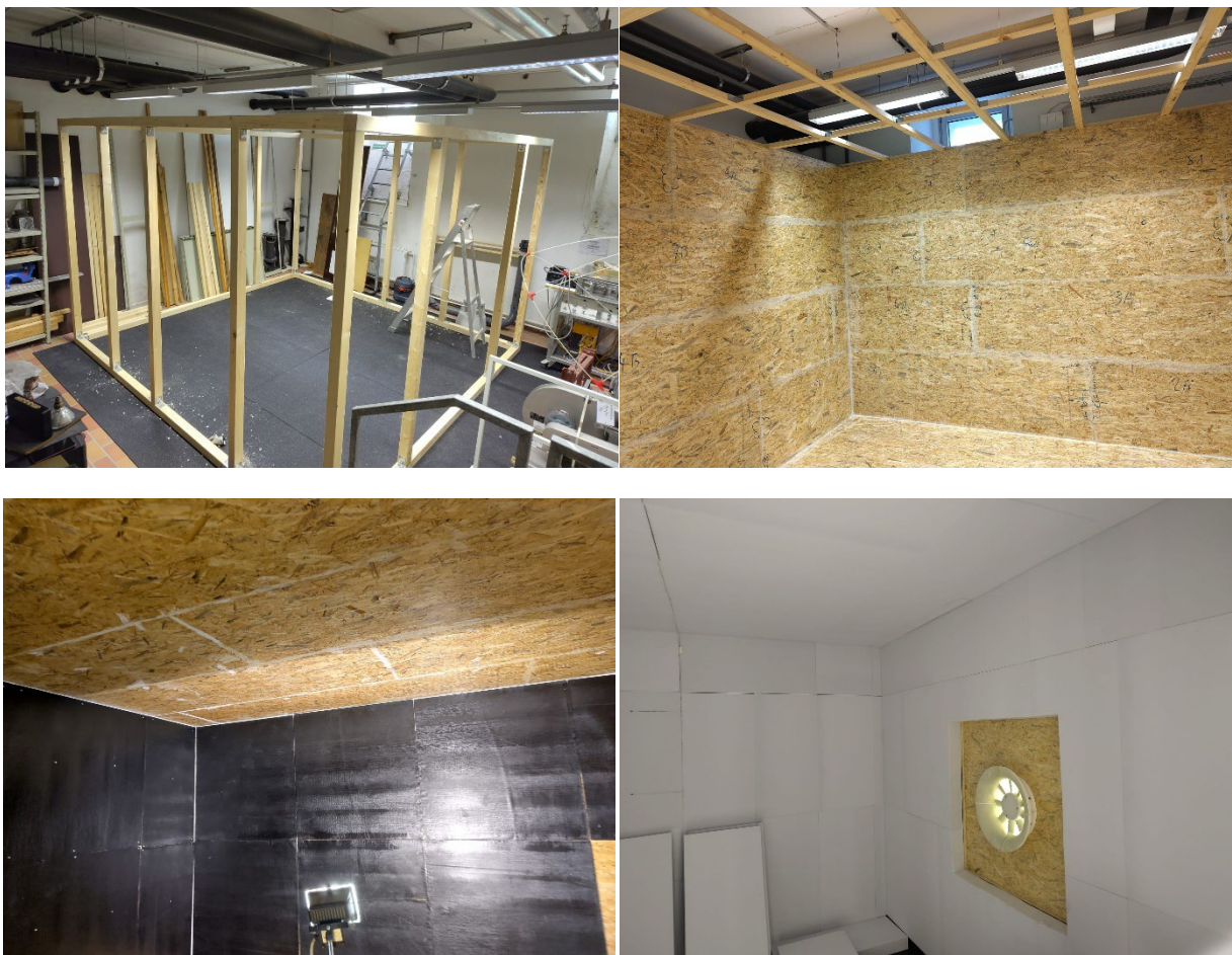
Abbildung 3: Evolution des Leistungsprüfstands DIN ISO 5801 im Eigenbau. Grundgerüst (oben links), Realisierung der Wandung (oben rechts), Einbringen der Bitumen-Schwerefolie zur Dämpfung (unten links) sowie der finalen 100-mm-BASOTECT®-Dämmung mit dargestelltem Prototyp zur Vermessung. (unten rechts). Bilder: Till Biedermann
