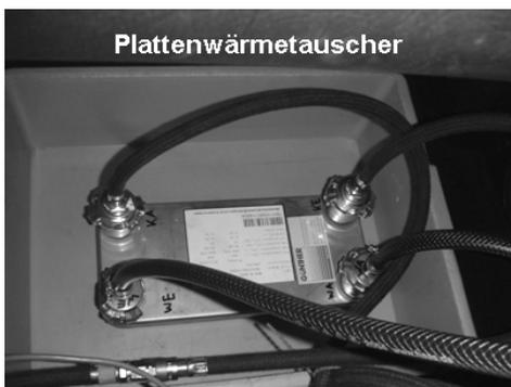
Abb.5. Plattenwärmetauscher des Kraftstoffkühlers
