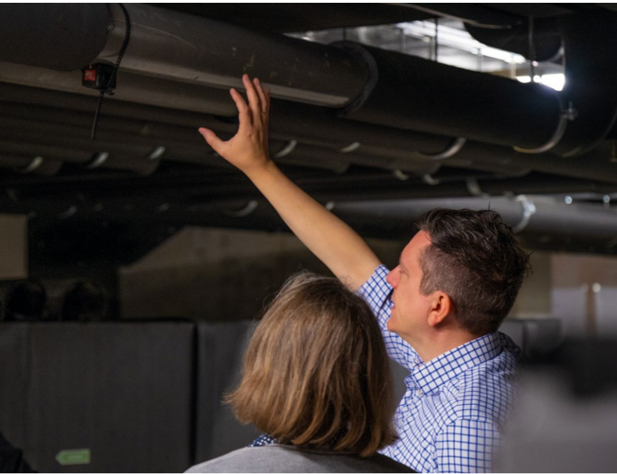
Prof. Dr.-Ing. Mathias Ehrenwirth zeigt die Stellen, an denen die Rohre von ihrer Ummantlung befreit wurden. Hier werden die Messinstrumente befestigt.
