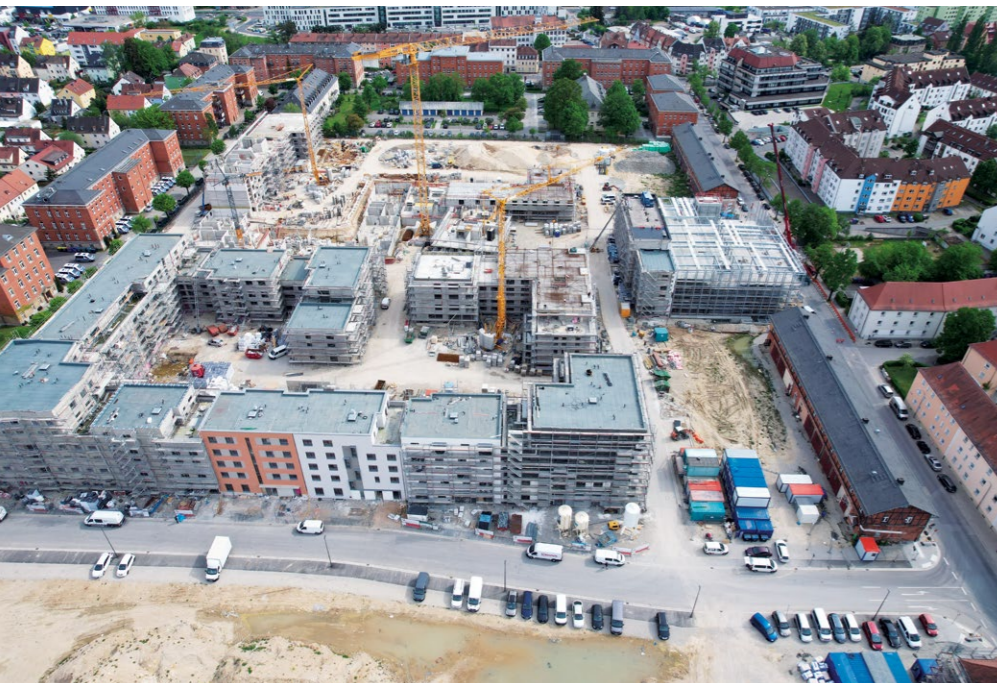
Auf dem Lagarde-Campus in Bamberg entsteht ein in Deutschland einzigartiges kaltes Nahwärmenetz, das große Teile des neuen Stadtquartiers mit Energie versorgt.
