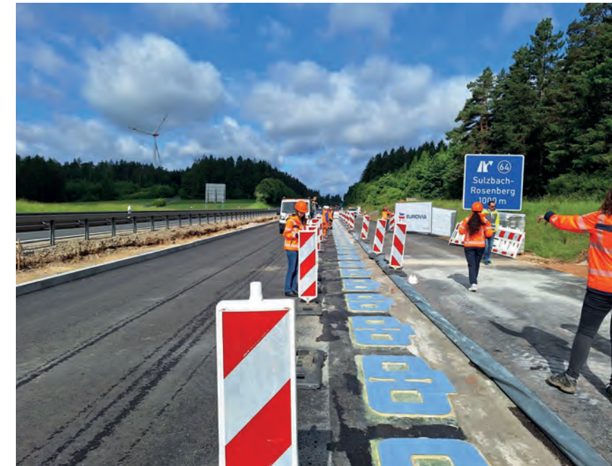
Verlegung der Ladespulen im Sommer 2025
