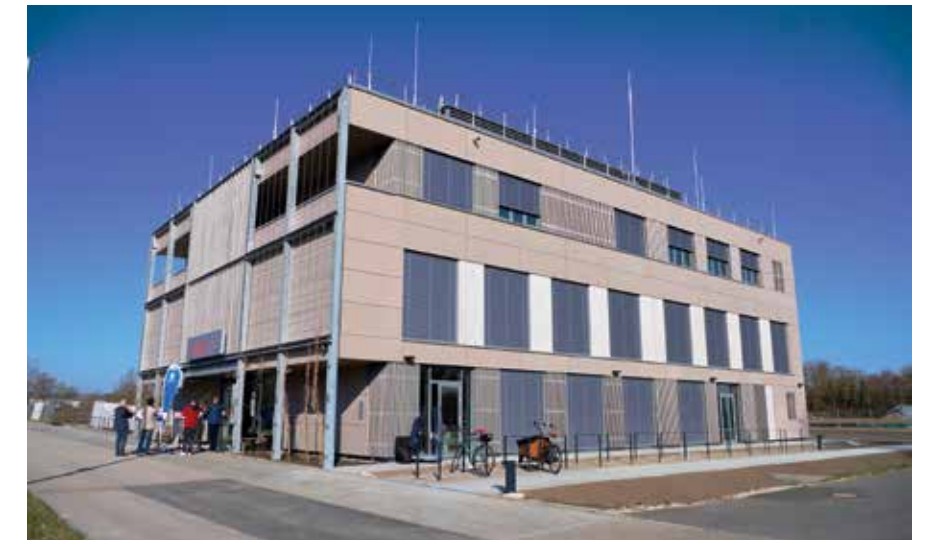
Das neue Modulgebäude der Ohm nutzt die Nürnberg School of Health für die Unterbringung der Gesundheitswissenschaften.
