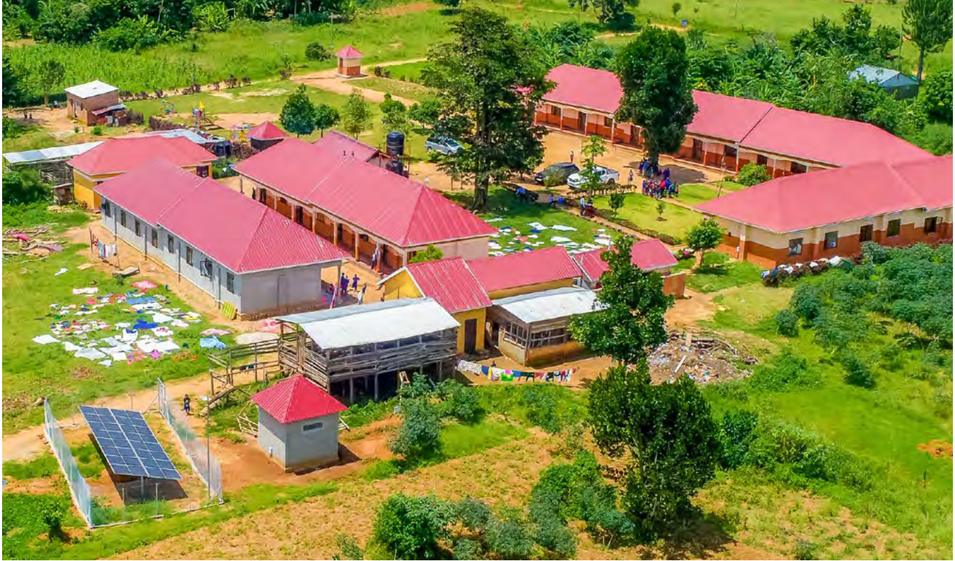
Das Schulzentrum und das Waisenhaus werden seit Oktober 2023 mit Solarstrom versorgt.
