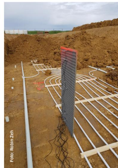
Beim Bau der Großkollektoranlage war die Gittermatte mit der Messtechnik noch sichtbar.
