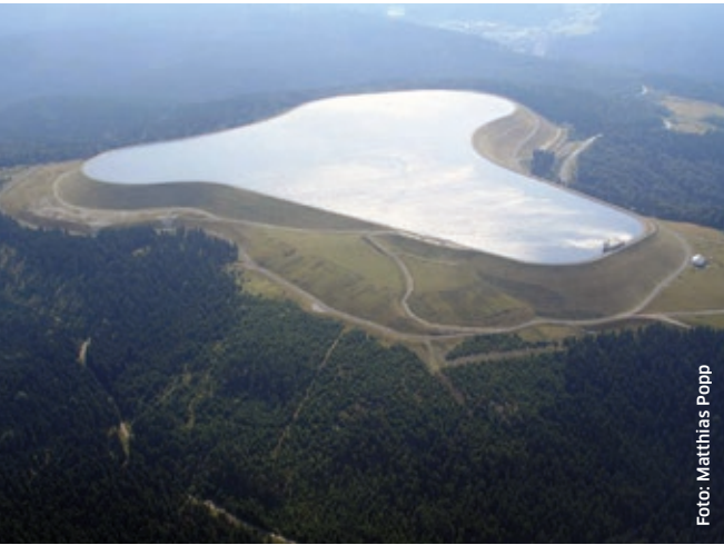
Das größte Pumpspeicherkraftwerk Deutschlands liegt in Goldisthal im Thüringer Wald. Die Dämme des Oberbeckens sind zum Teil über 40 Meter hoch.
