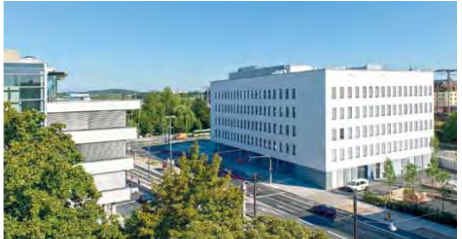
Heimat für rund 1.000 Studierende: Das neue Hochschulgebäude in der Bahnhofstraße 90.
