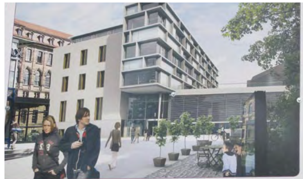
STADTERNEUERUNG ALTSTADT-SÜD UMBAU LUITPOLDHAUS FÜR DIE STADTBIBLIOTHEK
