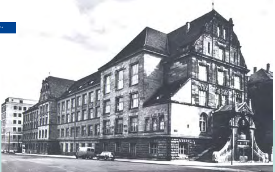
So sah der A-Bau um 1964 aus.
