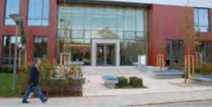
Neubau des Studienentrums am Klinikum Neumarkt, in dem auch die Krankenpflegeschule untergebracht ist.
