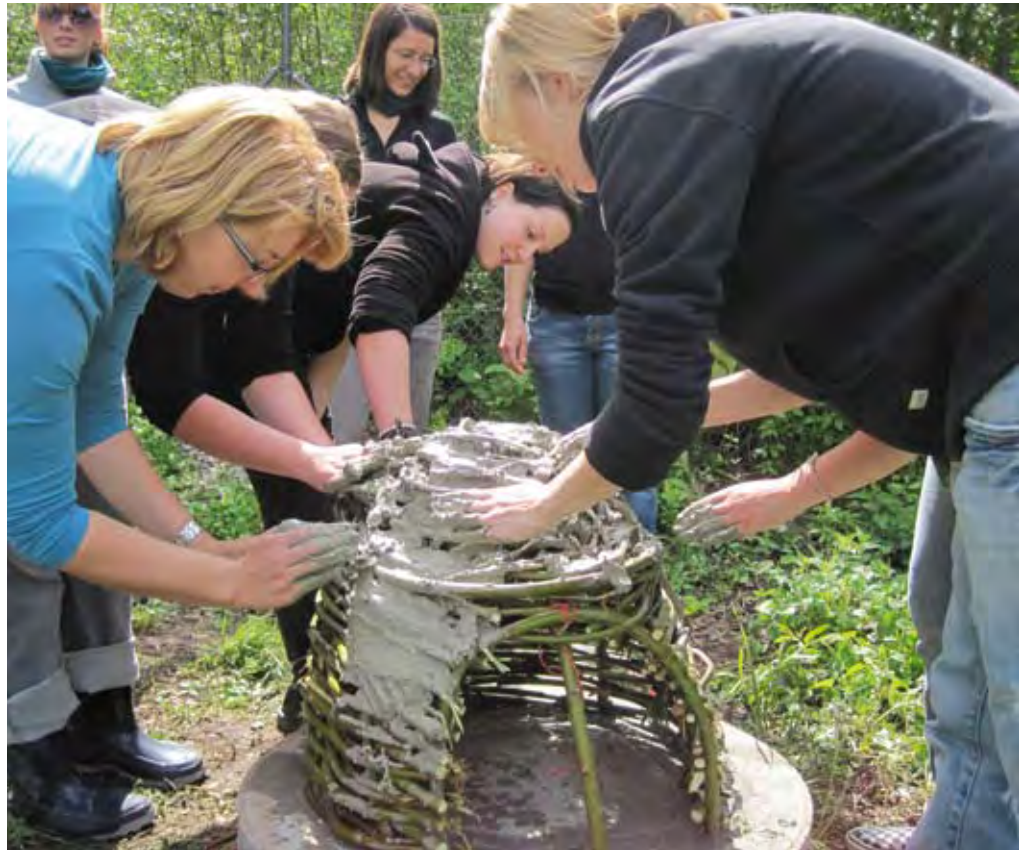
Hier wird das Flechtwerk verputzt.
