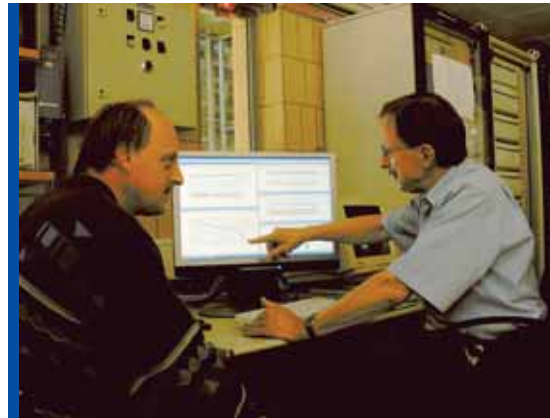
Blick in die Leitwarte mit Prozesssimulation, die zukünftig online erfolgen wird, d. h. das Simulationsprogramm vergleicht simulierte Werte mit Messwerten aus der laufenden Anlage.
