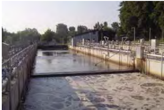
Inbetriebnahme der Stufe 2 1994
