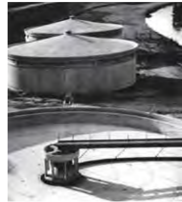
Tropfkörper kurz vor Inbetriebnahme
