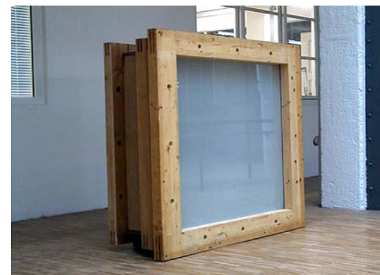
Abb. 6.11 Elemente sind u.a. Rahmenunterbau, Vorsatzrahmen und Glasscheibe (4 mm)
