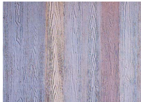
Abb. 8.5 Industrieschalung, Reckli-Strukturschalung 2/30 Havel, weißer Zement
