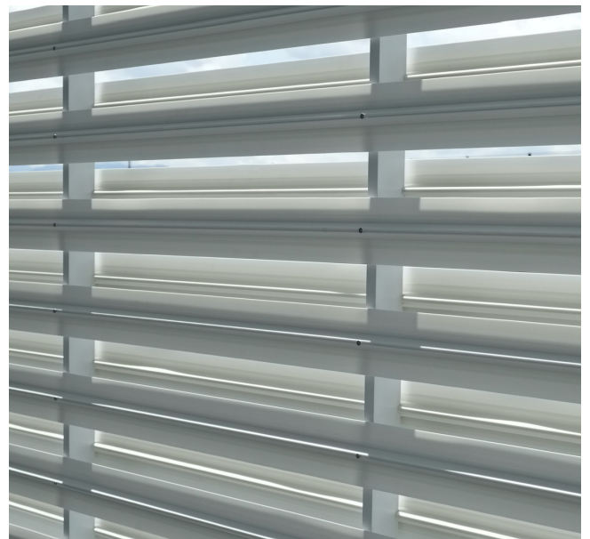
Abb. 1: „Fabiow“-Extrusionsprofile, die sowohl einlagig als auch mehrlagig (partiell beweglich) angeordnet werden können. Foto: Peter Bonfig
