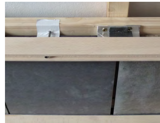
Abb. 105: Detail Befestigung Holzleichtbetonplatten mit Abdeckprofil aus Rotbuche
