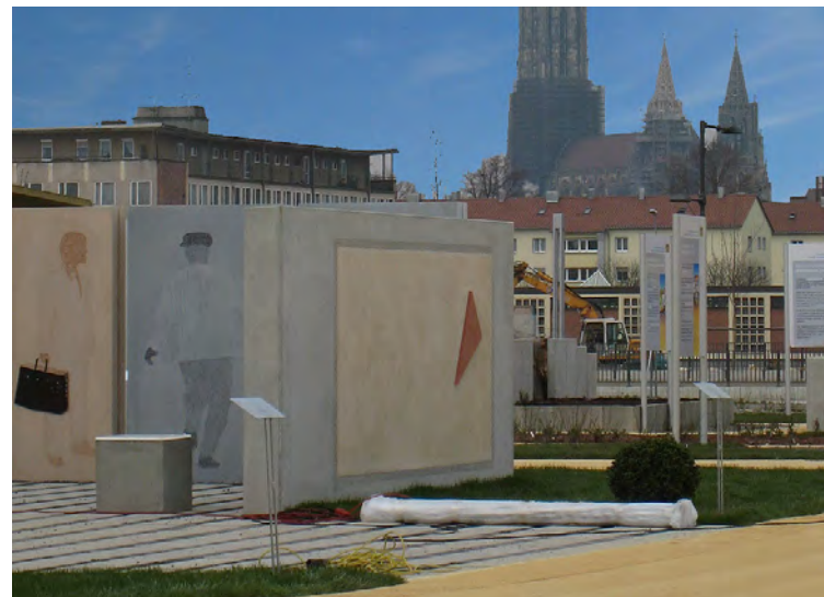
Abb. 2: Musterfläche Holzleichtbeton in Betonfertigteilwand (Landesgartenschau Neu-Ulm 4/2008)
