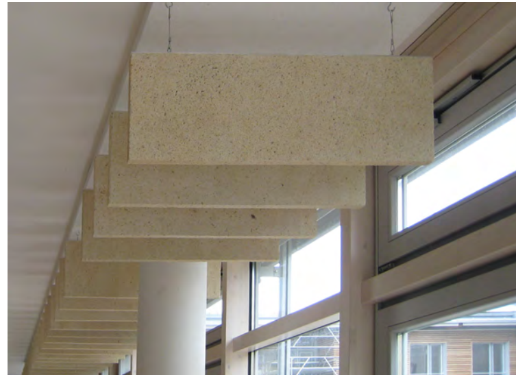
Abb. 1: Holzleichtbeton als Lamellen-Absorber (Fachhochschule Rosenheim 7/2008)
