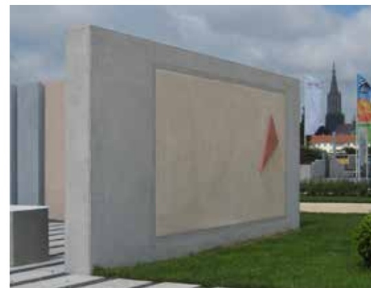
Holzleichtbeton für Sanierung von Außenwänden
