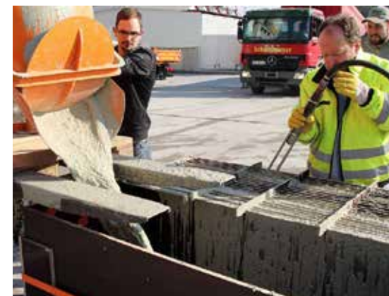
Abb. 18 Herstellung von HLB im Transportbetonwerk / Ausbreitmass (mitte)
