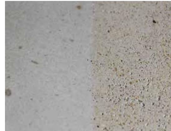
Abb. 3 HLB-Oberfläche, glatt geschalt (links) und angeschliffen (rechts)
