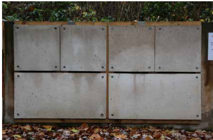
Abb. 49 Fassadenplattenteststand (TH Nürnberg/BI) – Fläche 2 (20.11.2013)
