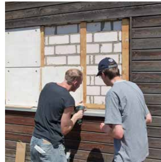
Abb. 35 Montage von HLB-Platten der Versuchsfläche, Variante 1
