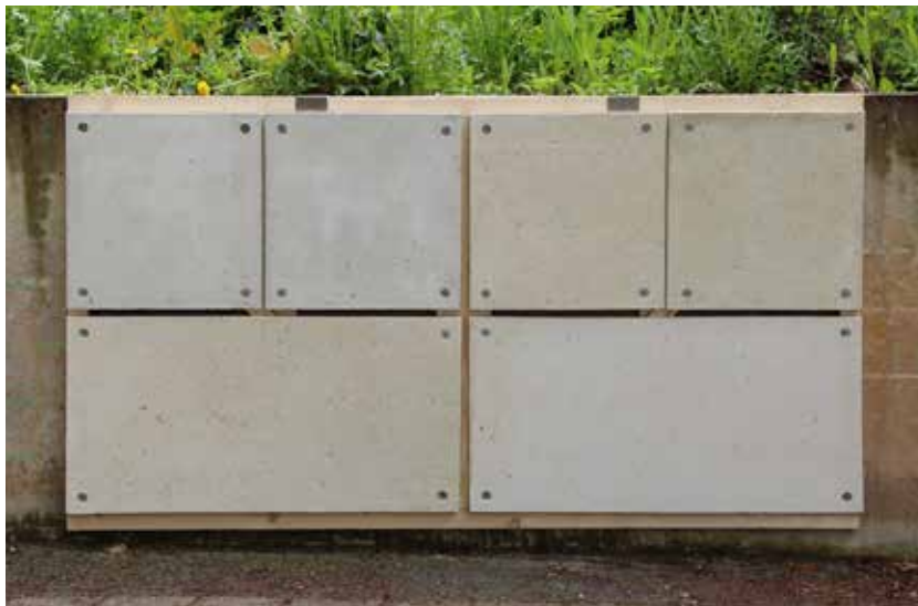
Abb. 48 Fassadenplattenteststand (TH Nürnberg/BI) – Fläche 2 (17.07.2013)
