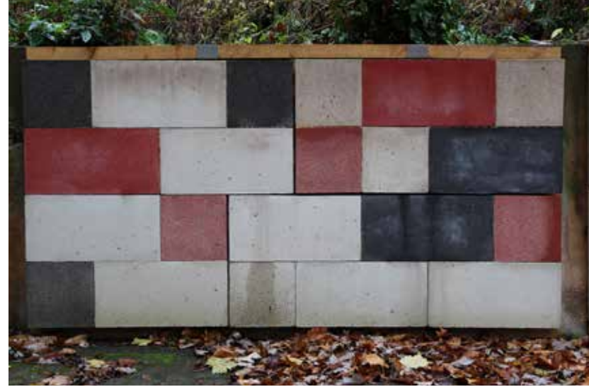
Abb. 47 Fassadenplattenteststand (TH Nürnberg/BI) – Fläche 1 (20.11.2013)
