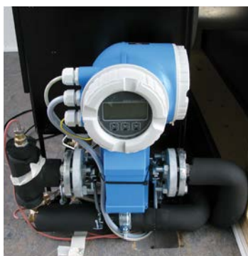
Abb. A15 Durchflussmessgerät, Vorlauf- / Rücklauf-temperatur (THN-AR)
