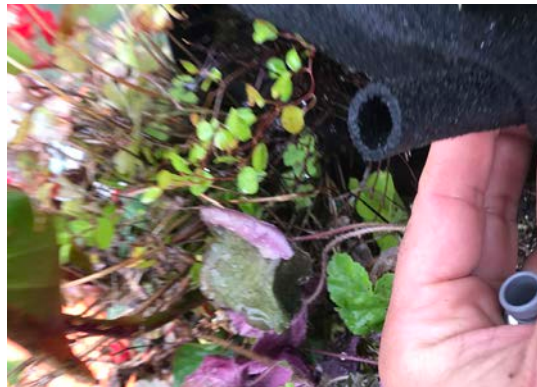
Abb. A38 Schaden an einem Bewässerungsschlauch (IBP)
