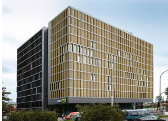
Abb. 2 München, Bürogebäude/ Laimer Würfel (2007); plan2 Architekten, München (TROX 3/2019)
