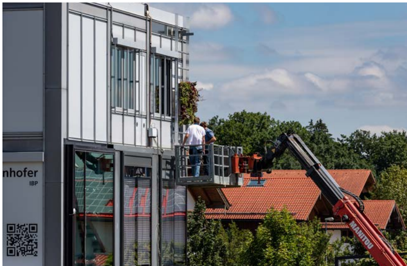
Abb. 78 Anbringen des Begrünungssystems von Verticalgreendesign (VGD) (07.08.2020) (IBP)
