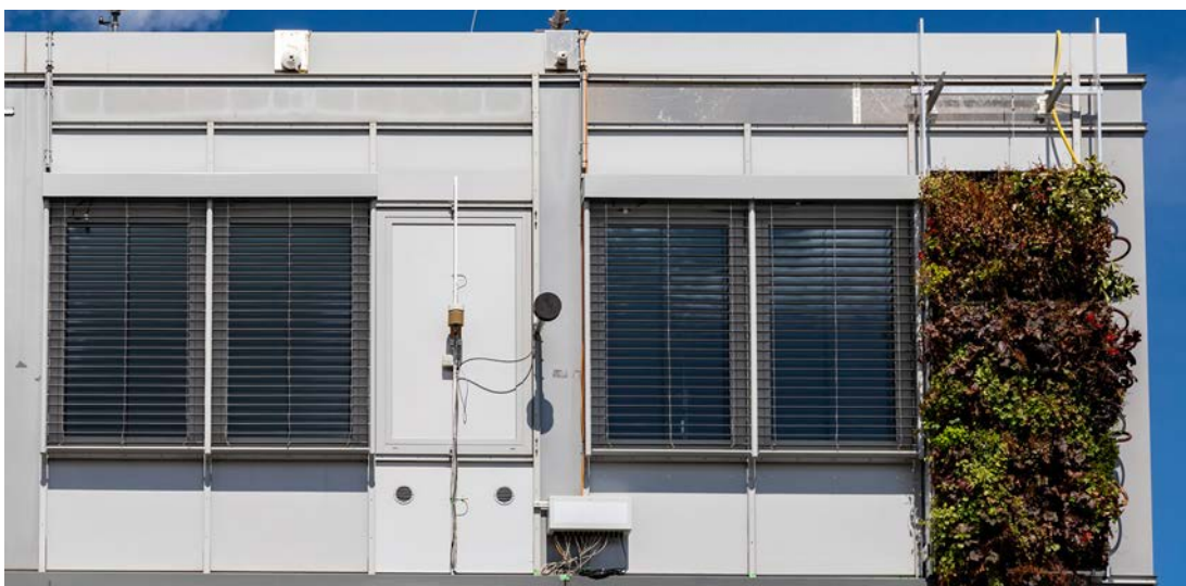
Abb. 89 Außenansicht des Messaufbaus an der Fassade. (IBP)
