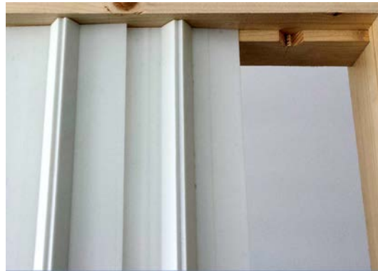
Abb. 78: Rahmen mit Kerben zur Profil-Aufnahme (THN-AR)
