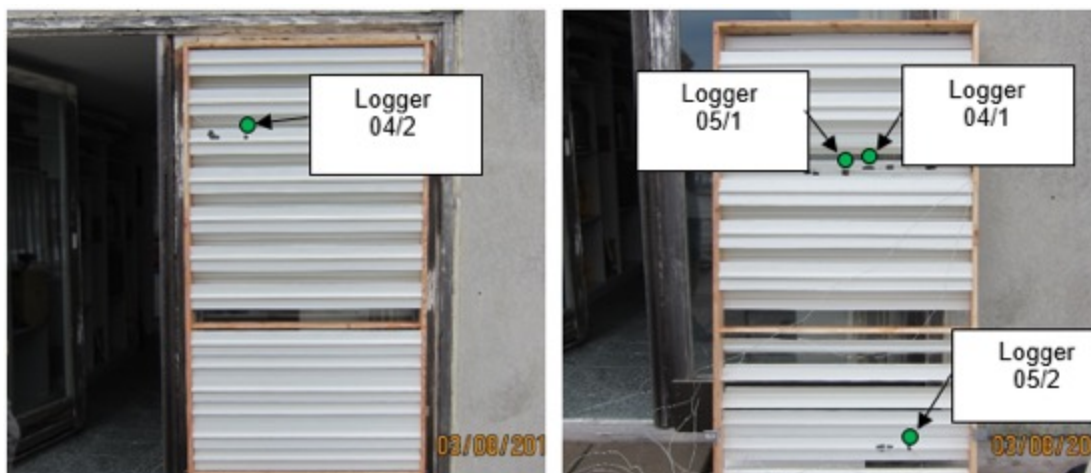
Abb. 127: Demonstrator „KB-Gebäude“ mit Messstellen (links: Vorderseite, rechts: Rückseite) (THN-ieg)
