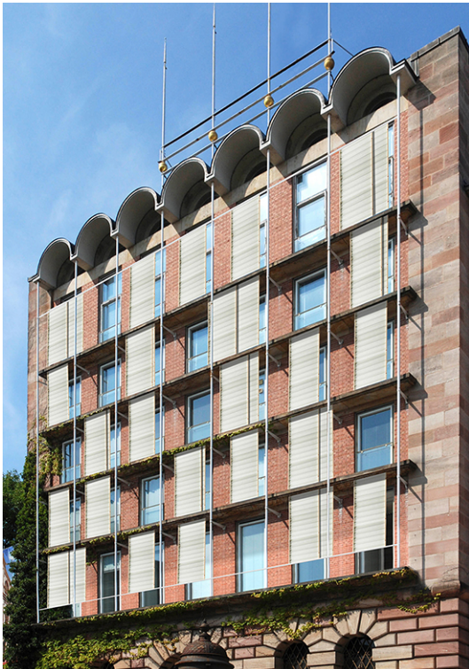
Abb. 88: Einbausituation Fassadenladen: Klinker-/Natursteinfassade, Verwaltungsgebäude (THN-AR)
