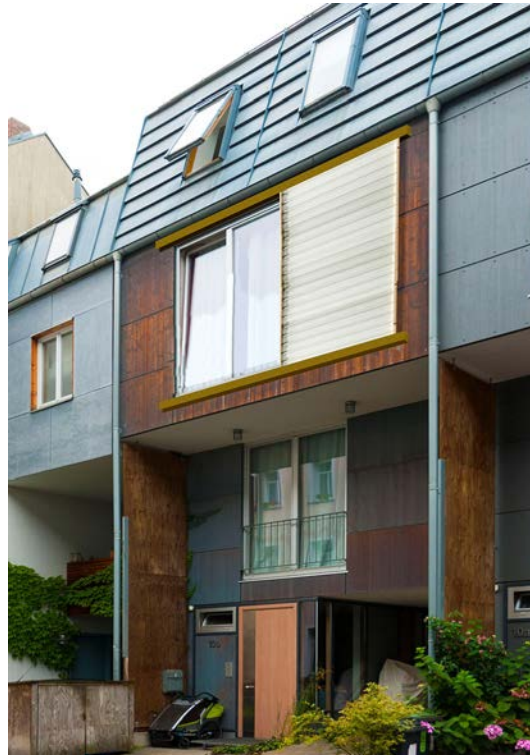
Abb. 89: Einbausituation Fassadenladen: Holz-fassade, Wohngebäude (THN-AR)
