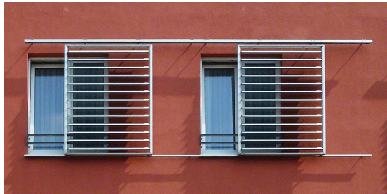
Abb. 87: (links) Notwendige Schnittstellen, 1 (Massive) Wand – Außenkante, 2 Außenkante – Führungsschiene, 3 Führungsschiene – Fassadenladen, (THN-AR) (rechts) Horizontaler Schiebeladen (Leichtmetall) (Roland Krippner)
