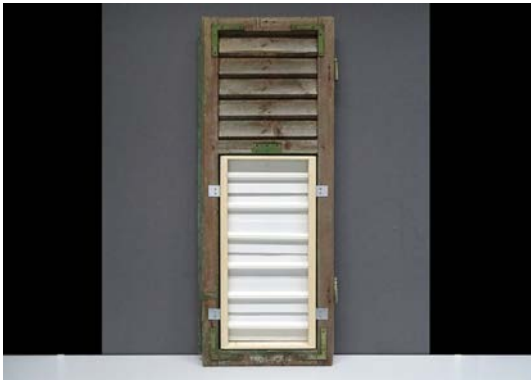
Abb. 81: Klappladen (Fichte): Belegung mit Fassadenladenprofil (THN-AR)
