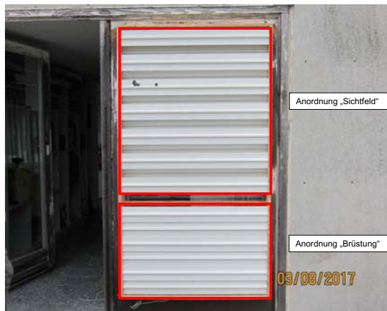
Abb. 125: Ansicht des zu untersuchenden Fassadenladens (THN-ieg)
