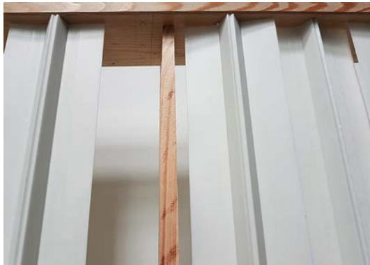
Abb. 77: Rahmen mit Zapfen zur Profil-Aufnahme (THN-AR)
