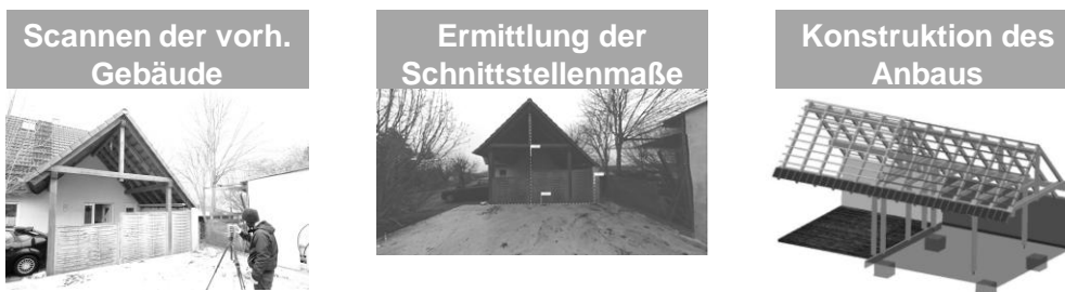
Abbildung 21: Vermessung bestehender Bausubstanz und Anbaukonstruktion
