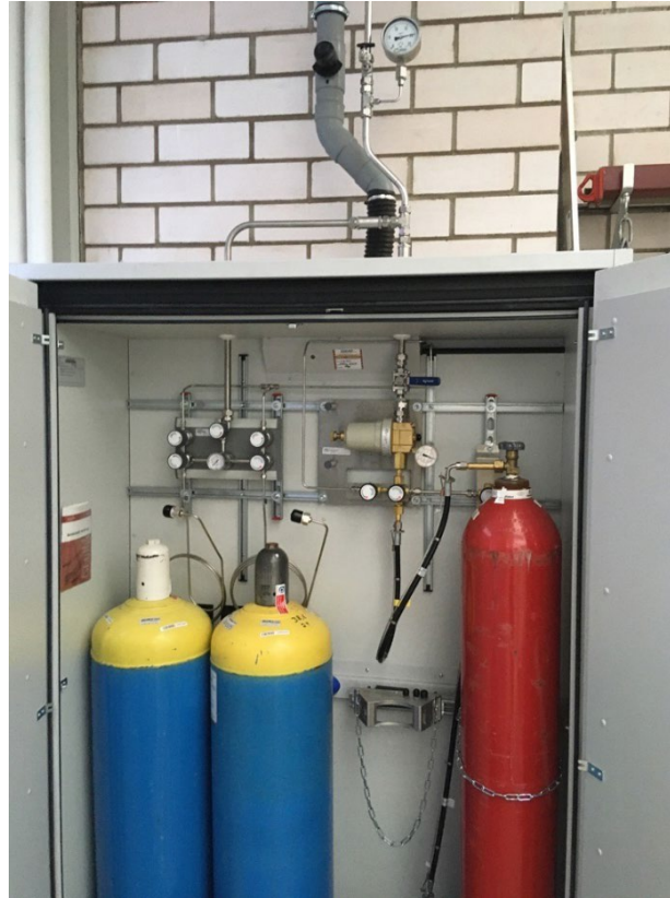
Abbildung 4: Gasflaschenschrank nach Umbaumaßnahmen (Linke Seite: Umrüstung auf Edelstahl Entspannungsstation). Bild: Thomas Untheim
