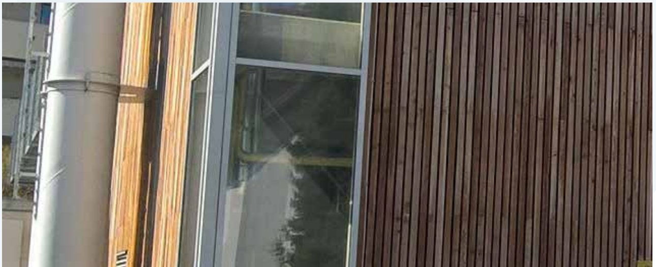
Abbildung 1: Wärmenetze in ländlichen Regionen: Heizhaus zur Erzeugung erneuerbarer Fernwärme (Foto: Alexander Schrammek)
