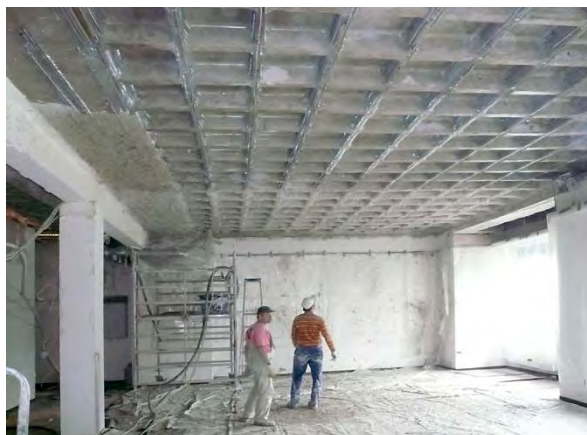
Abbildung 15: Brandschutzsanierung der Decken
