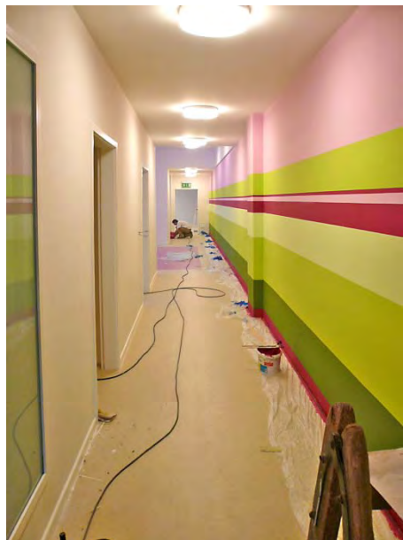
Abbildung 17: Wand- und Bodenarbeiten
