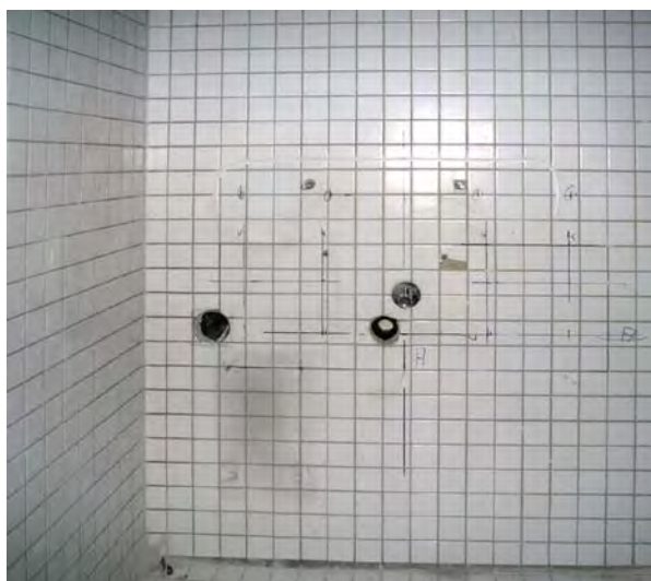
Abbildung 16: Sanitärbereich während des Umbaus
