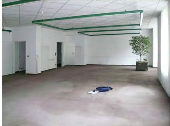
Abbildung 7: Eingangsbereich bei der ersten Begehung
