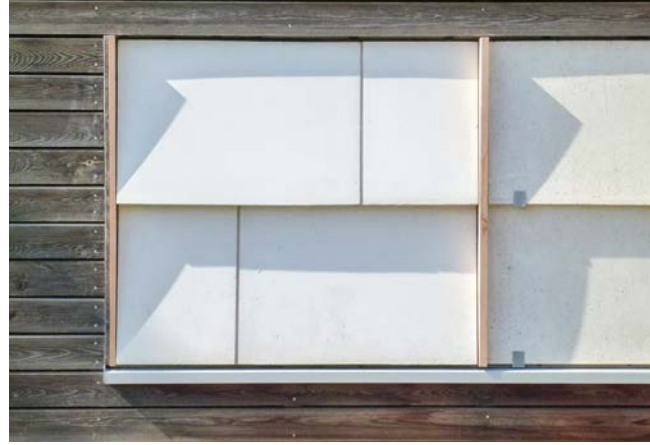
Die sogenannten Fassaden-Sandwich-Elemente eignen sich auch als Außenwände.
