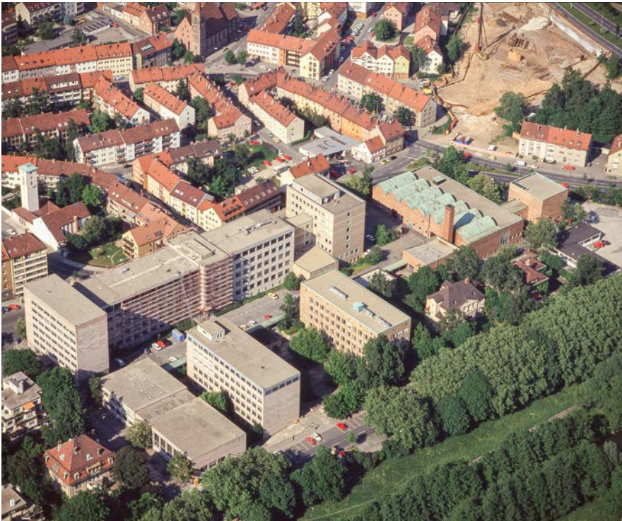
Blick auf das Stammgelände der Hochschule am Keßlerplatz. Im Hintergrund ist die Baustelle für das Hochschulgebäude in der Wassertorstraße 10 zu sehen (1984).
