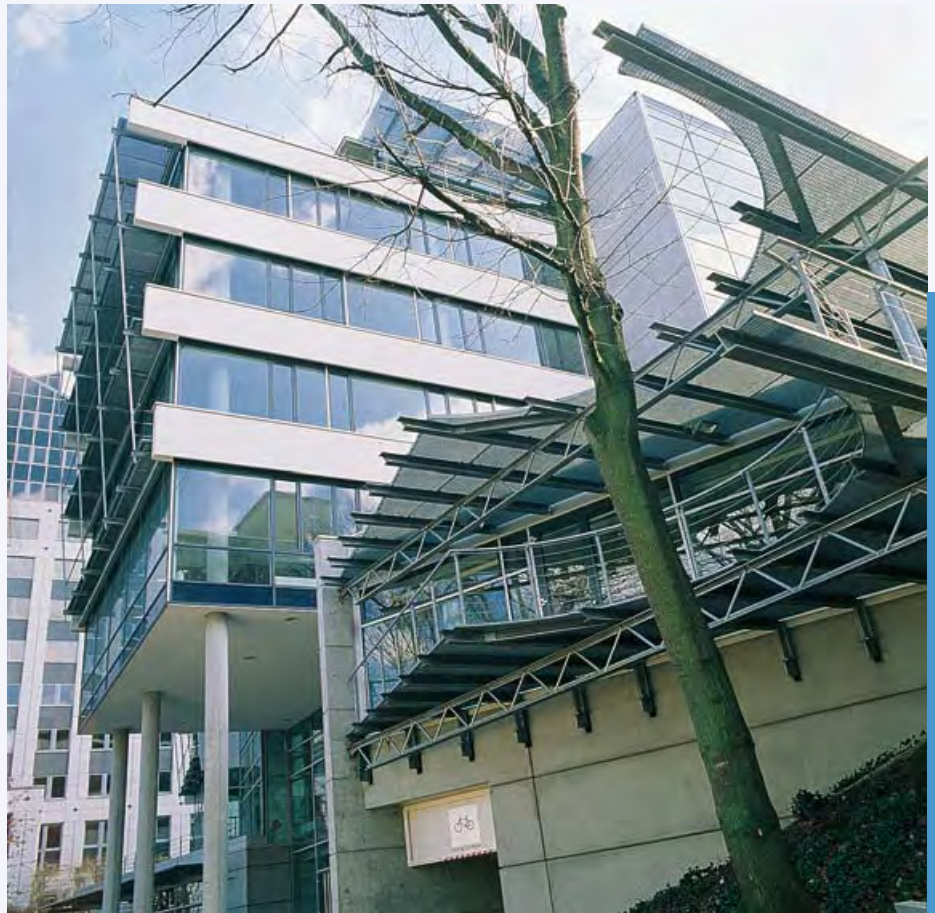
Neubau in der Bahnhofstraße: 1999 wurde der Campus 3 eröffnet. Hier sind die Fakultät Betriebswirtschaft und die Fakultät Sozialwissenschaften untergebracht. Das Gebäude besticht durch seine moderne Architektur.
