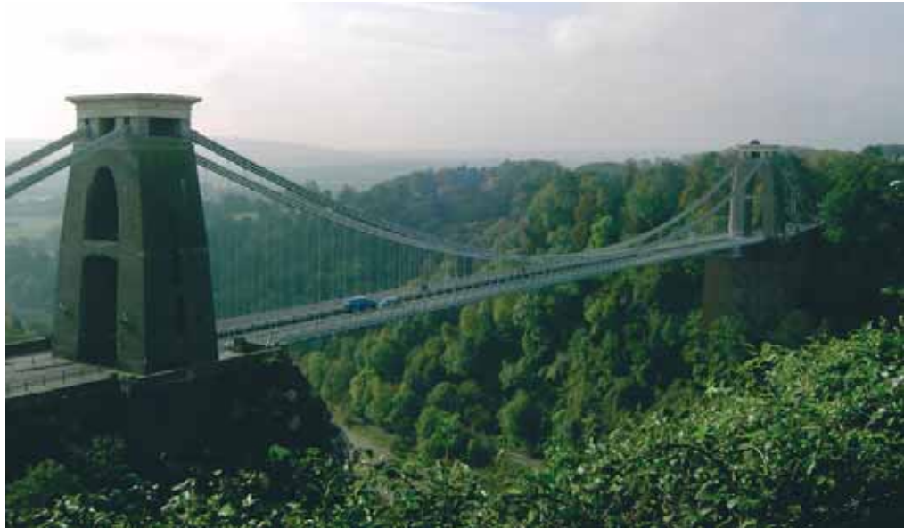
Bristols Wahrzeichen, die Clifton Suspension Bridge, spannt sich in 75 Meter Höhe über die Avon-Schlucht.
