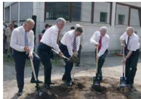
Mit Eifer bei der Sache. Hochbauamts-Direktor Peter Loew, Bürgermeister Horst Foerther, Wissenschaftsminister Thomas Goppel, Rektor Herbert Eichele und AC-Dekan Karlheinz Jacob (v. l.) beginnen mit dem Aushub der Baugrube für den Chemie-Neubau
