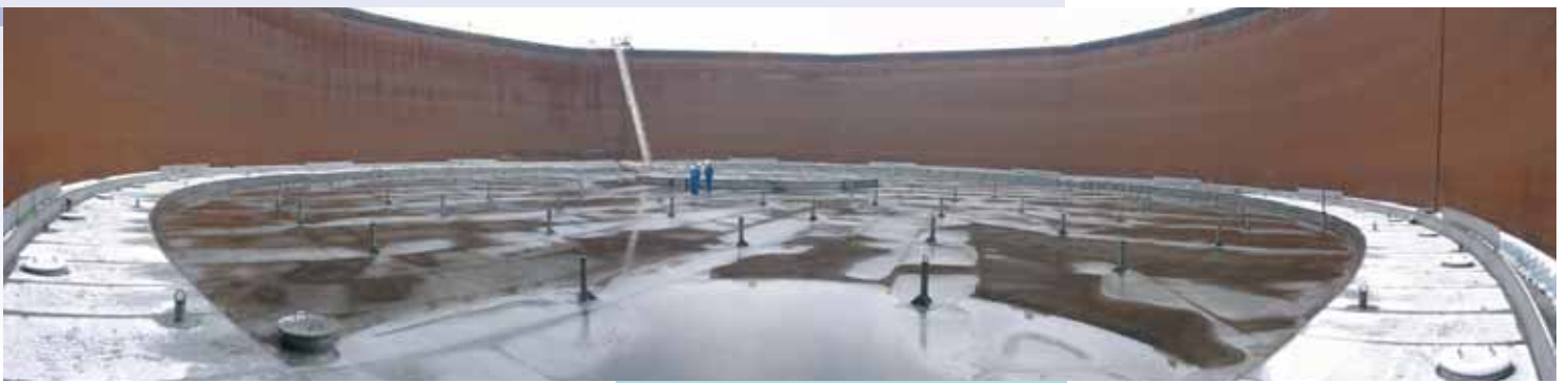
Platz für bis zu 100 Millionen Liter. Ein leerer Lagertank für petrochemische Flüssigkeiten
